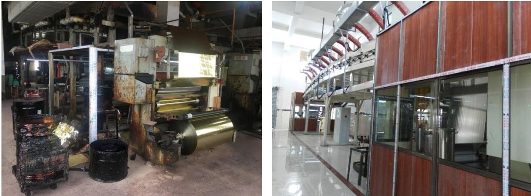
整改前后镀膜车间现场（左图为整改前，右图为整改后）
